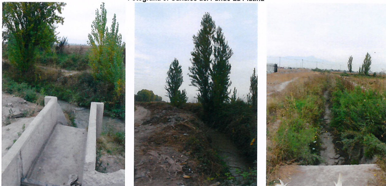
Fotografía 6: Canales del Fundo La Platina
