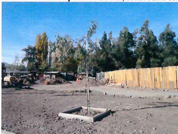
Fotografía 2: Construcción conjunto habitacional, Sector Barrio Santo Tomas
