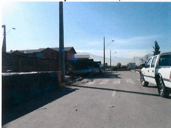
Fotografía 1: Construcción conjunto habitacional, Sector Barrio Santo Tomas
