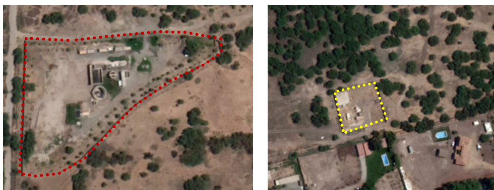
Figura 20: Planta de Tratamiento de Aguas Servidas y Planta de Tratamiento de Agua Potable
