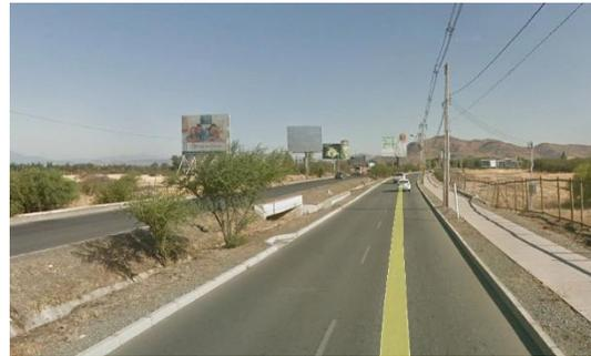
Tiene un carácter desplazador en términos de su diseño y velocidades de desplazamiento, con un ancho existente de 25 metros aprox., y un ancho proyectado de 80 metros. Actualmente cuenta con dos pistas por sentido.
