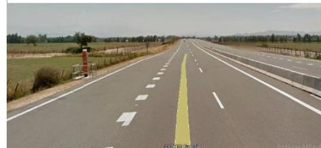
Es una ruta bidireccional de carácter desplazador, con dos calzadas por sentido. Las vías de menor jerarquía traspasan en desnivel para no impedir su continuidad.
