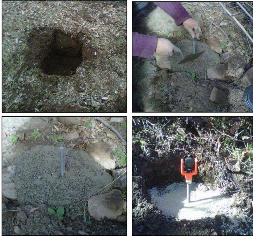
**Figura 7.** Secuencia de instalación de Miniprismas
